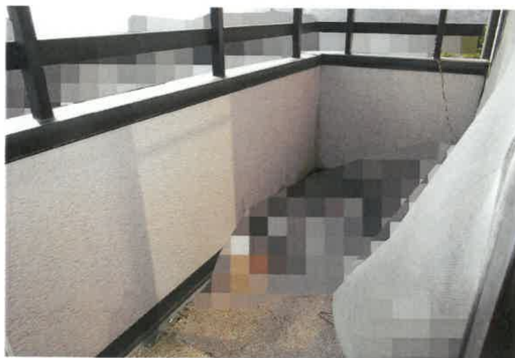
写真18 2階バルコニー
