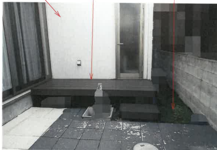
物件2建物 ウッドデッキ 物件1土地
