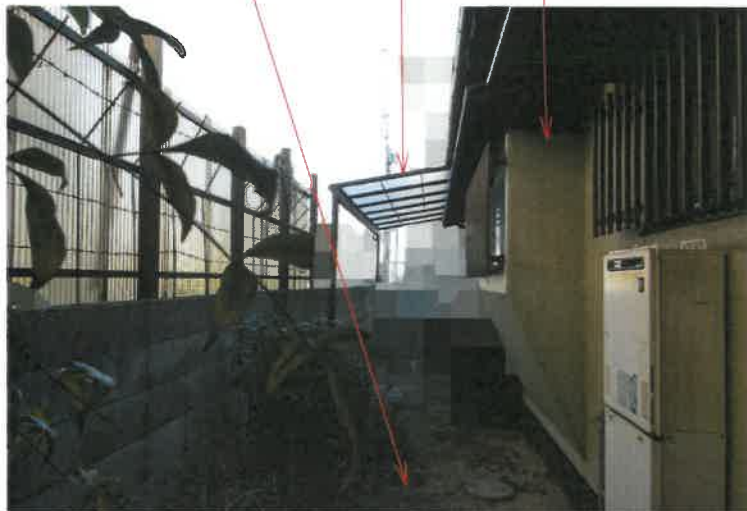
写真5 物件1土地 下屋 物件2建物
