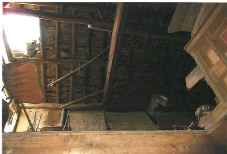
写真2 4 附属建物符号4・中央側物置（屋根部分）
