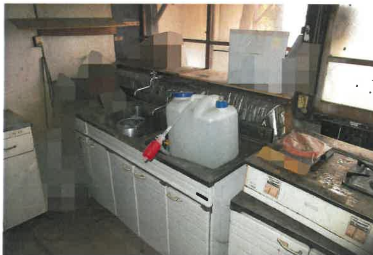
写真9 主建物・台所
