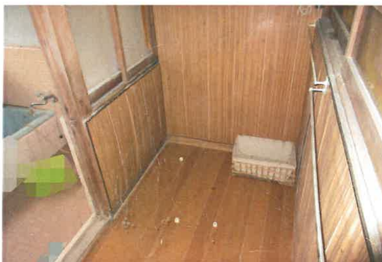
写真20 附属建物符号1・脱衣所
