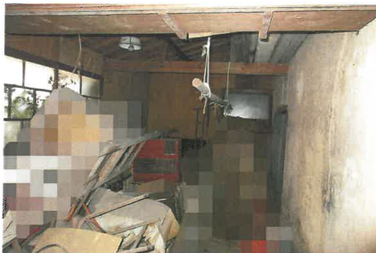
写真25 附属建物符号4・北側物置
