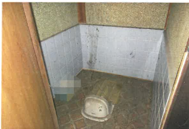
写真26 附属建物符号4・トイレ
