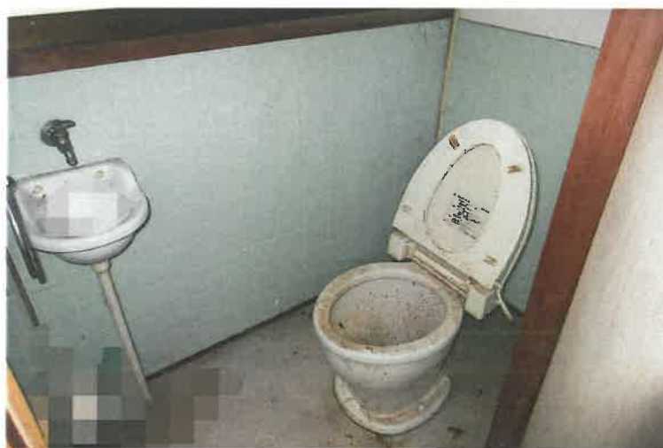
写真18 主建物・トイレ
