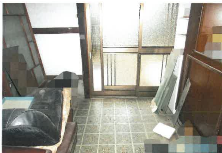
写真6 主建物・玄関土間
