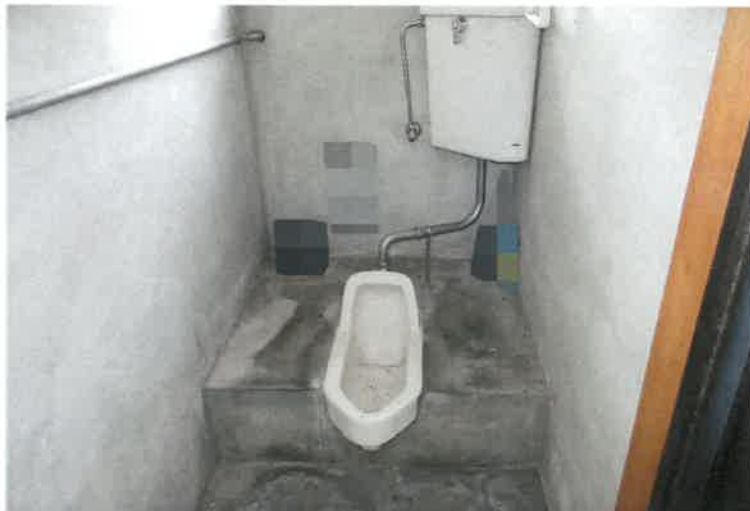
写真5 物件2 建物・1階トイレ
