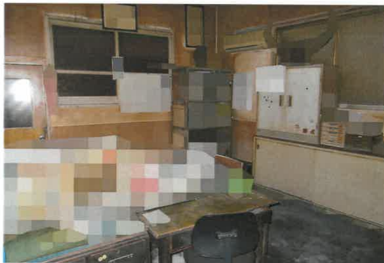
写真8 物件2建物・1階中央事務室
