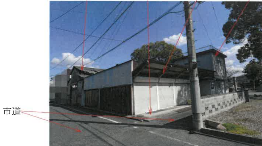
写真1 下屋状構築物 物件1土地 物件3建物 物件2建物
