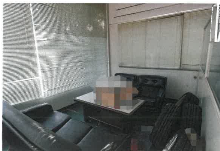
写真6 1階事務所東側部分
