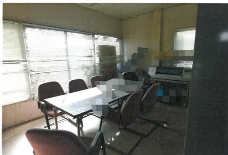
写真11 2階事務所東側部分
