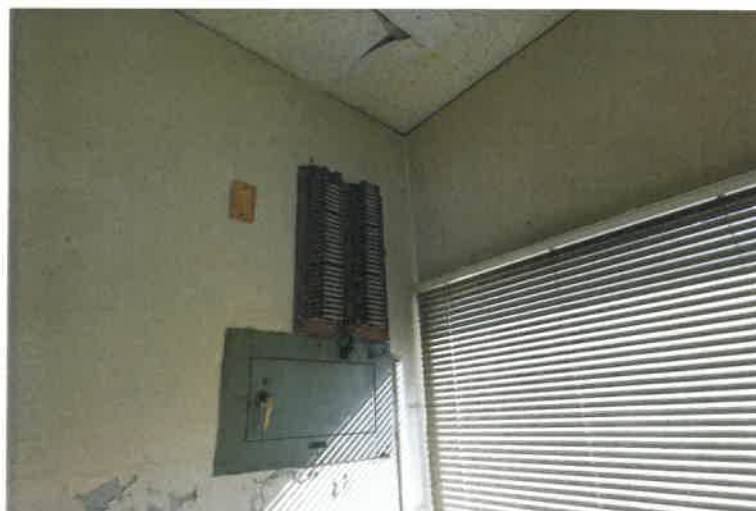
写真1 4 2階事務所北東側角部分
