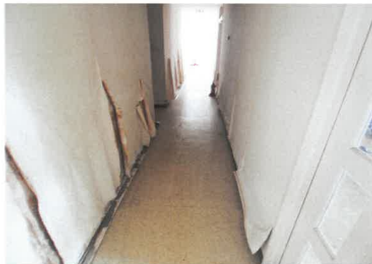
写真36 (物件8主建物2階廊下)
