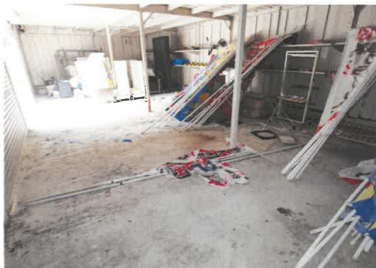
写真51 (物件18符号1附属建物車庫)
