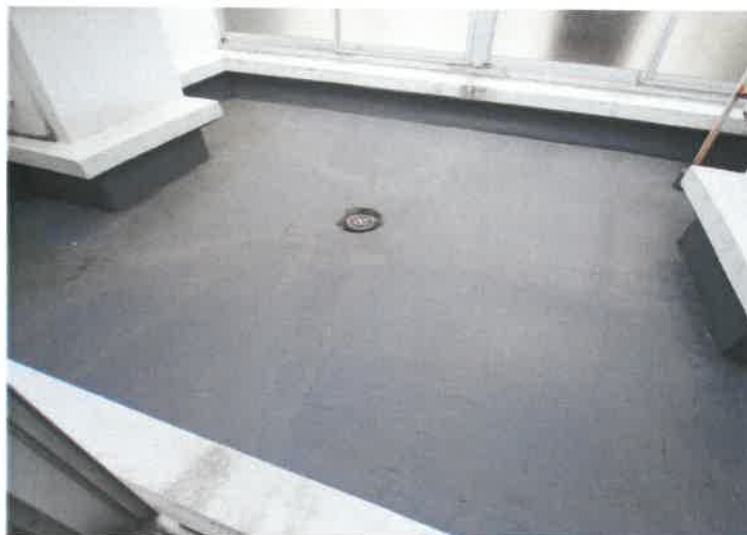
写真 3 9 (物件 8 主建物 2 階北側中庭)
