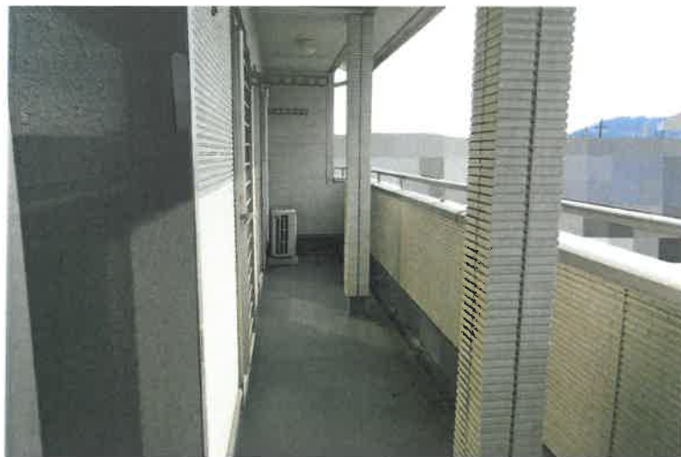
写真22 2階バルコニー
