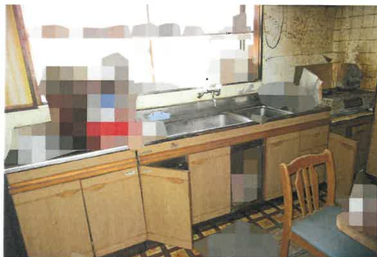
写真14 1階DK (キッチン部分)
