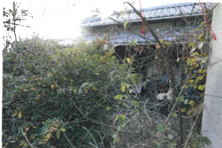
目的の外建物 物件3建物
