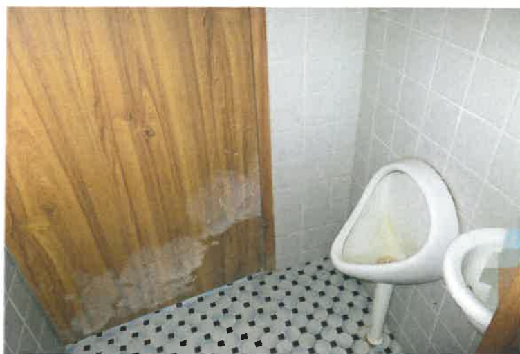
写真11 1階北側トイレ
