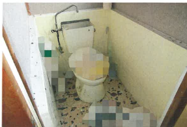
写真9 1階東側トイレ
