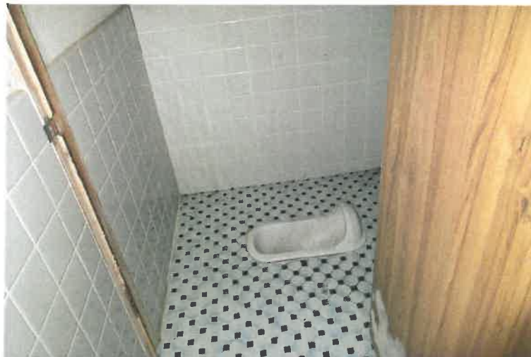
写真10 1階北側トイレ
