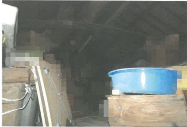
写真19 宙2階(附属建物符号3)内の状況
