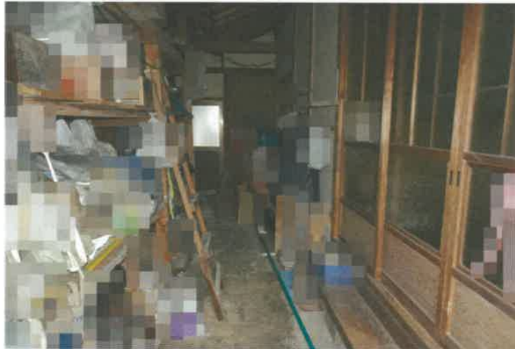
写真20 附属建物符号1内の状況
