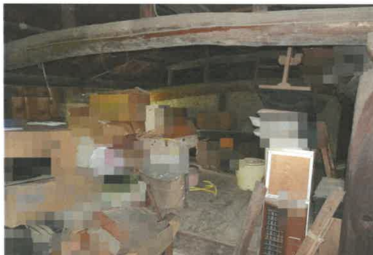
写真18 宙2階(主である建物)内の状況
