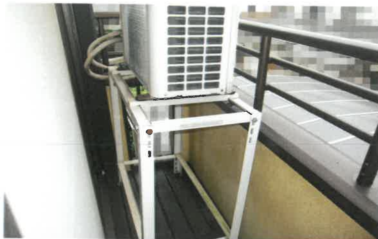
写真19 2階南東側ベランダ
