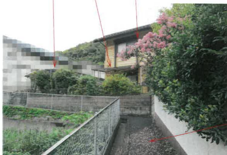
写真6 カーポート 下屋 物件2建物
