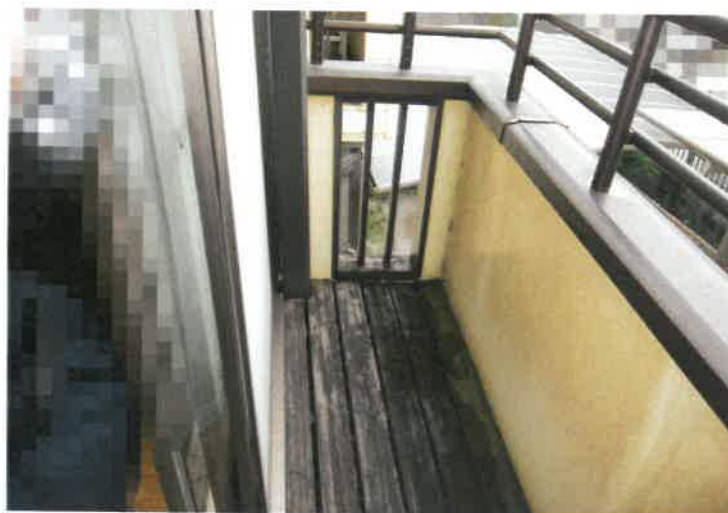
写真21 2階南西側ベランダ
