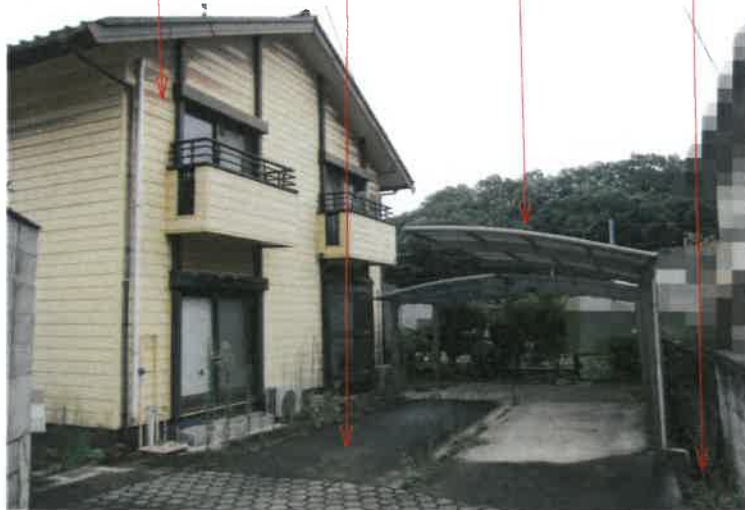
写真3 物件2 建物 物件1 土地 カーポート 側溝
