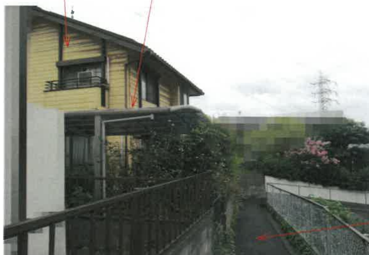
写真5 物件2建物 カーポート
