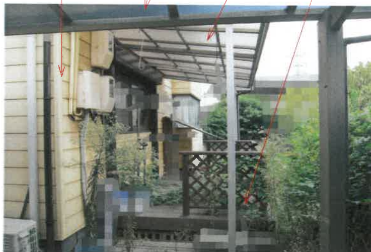
写真4 物件2建物 カーポート 下屋 ウッドデッキ
