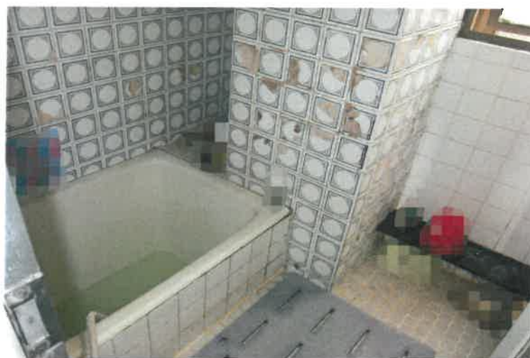
写真2 3 物件7建物・2階浴室
