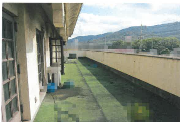
写真35 物件7建物・2階ベランダ
