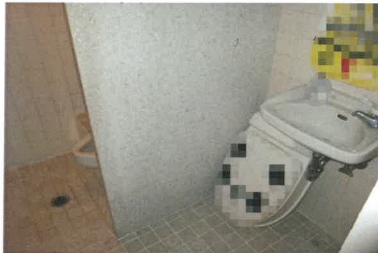
写真20 物件7建物・2階トイレ
