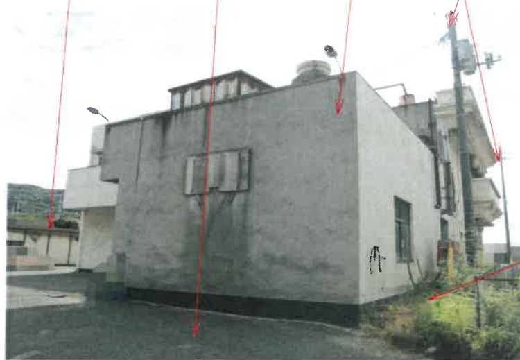
写真7 物件8建物 物件2土地 物件7建物 電柱
