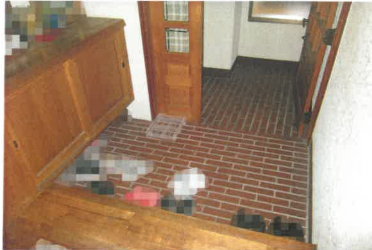
写真19 物件7建物・2階玄関
