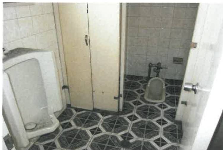
写真18 物件7建物・1階元店舗・トイレ
