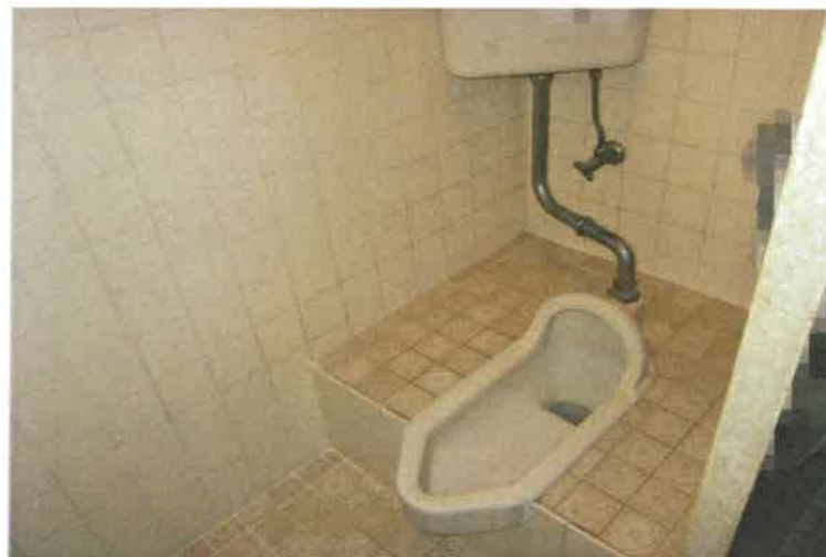
写真21 物件7建物・2階トイレ
