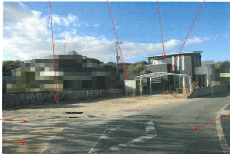
写真2 物件1土地 簡易物置 物件3建物 カーポート
