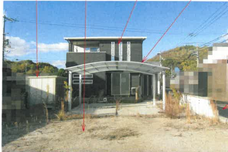
写真4 簡易物置 物件1土地 物件3建物 カーポート
