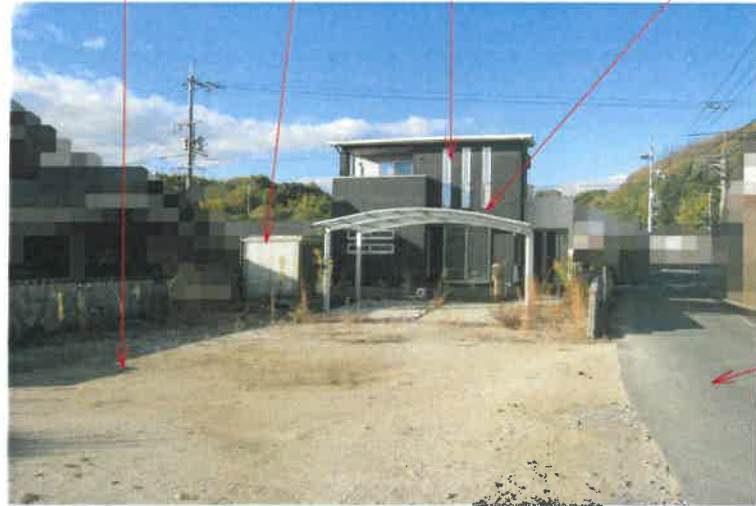
写真1 物件1土地 簡易物置 物件3建物 カーポート
