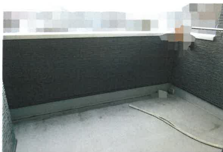
写真17 2階バルコニー
