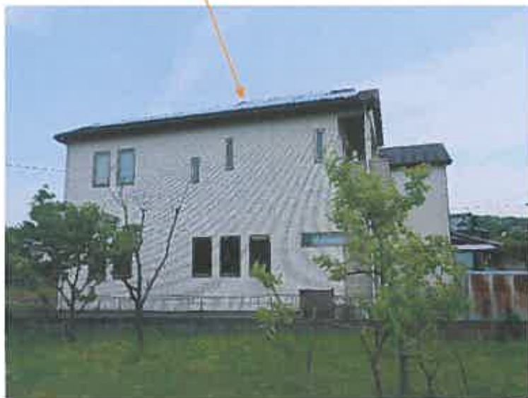
写真2 太陽光発電設備（ソーラーパネル）
