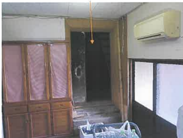
写真17 附属建物符号1の入口
