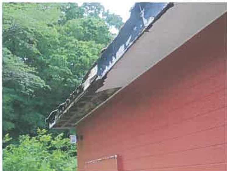
写真6 庇の腐食
