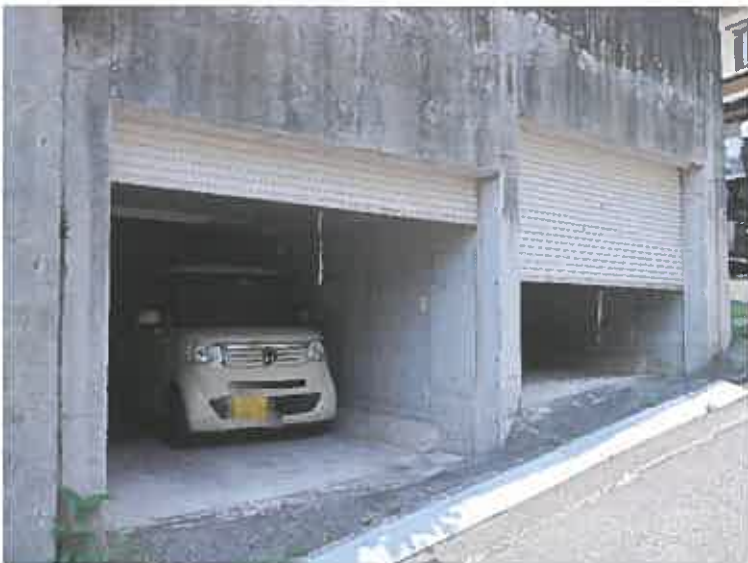
写真3 附属建物（車庫）
