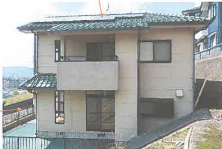
写真 3 太陽光発電設備（ソーラーパネル）
