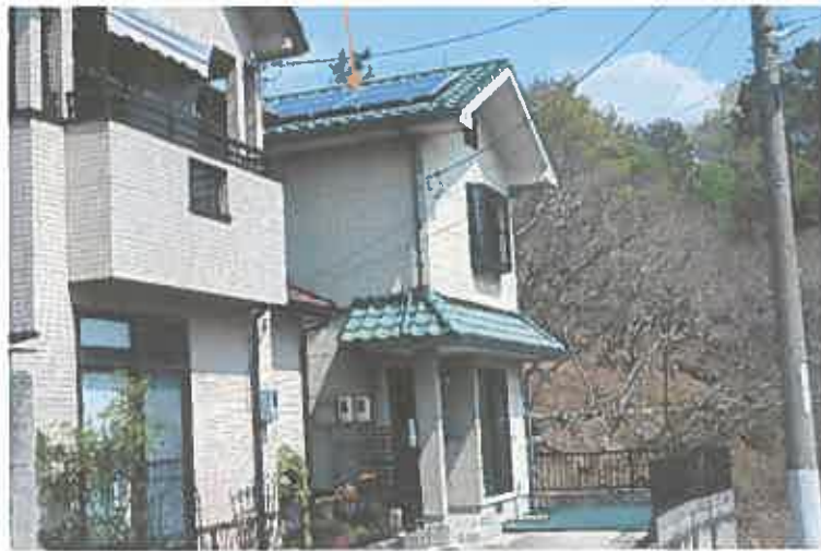
写真 2 太陽光発電設備（ソーラーパネル）
