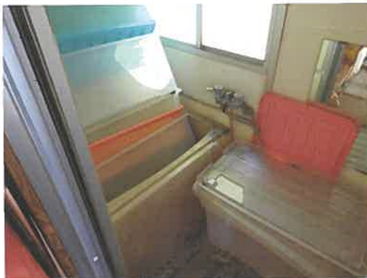
写真18 (未登記附属建物内)
