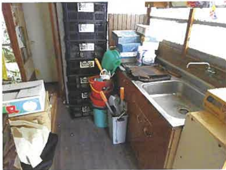
写真16 (未登記附属建物内)
