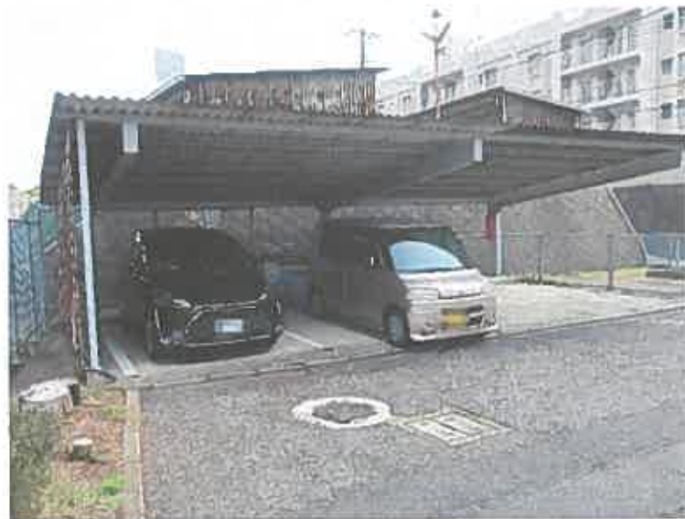
写真5 物件10建物（車庫）
