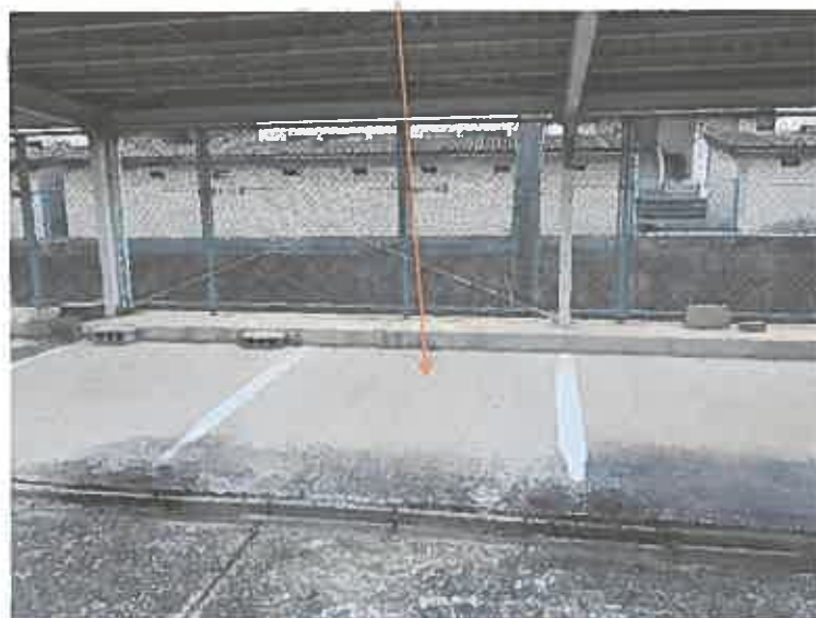
写真8 物件12建物(車庫)区画B-10部分
