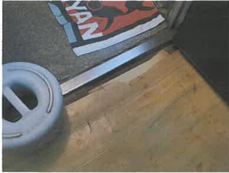
写真13 床板の腐食
