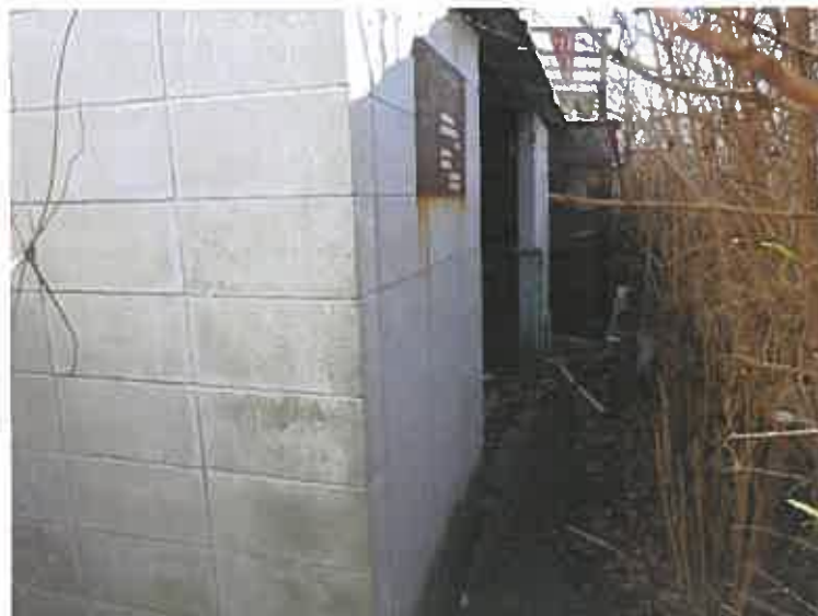
写真 3 0 (本件建物のプロハン庫)
