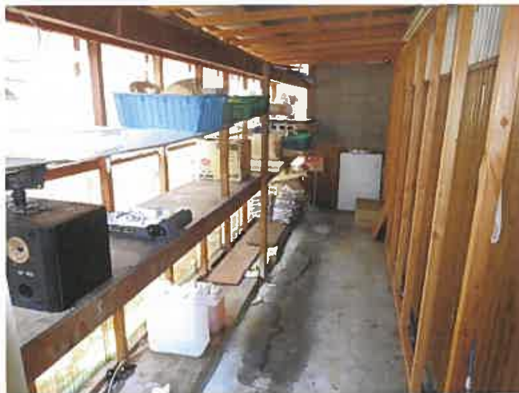
写真 2 9 (本件建物 1 階 (工作物内))
