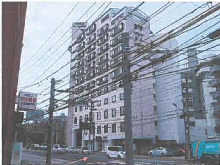
主要地方道広島三次線
