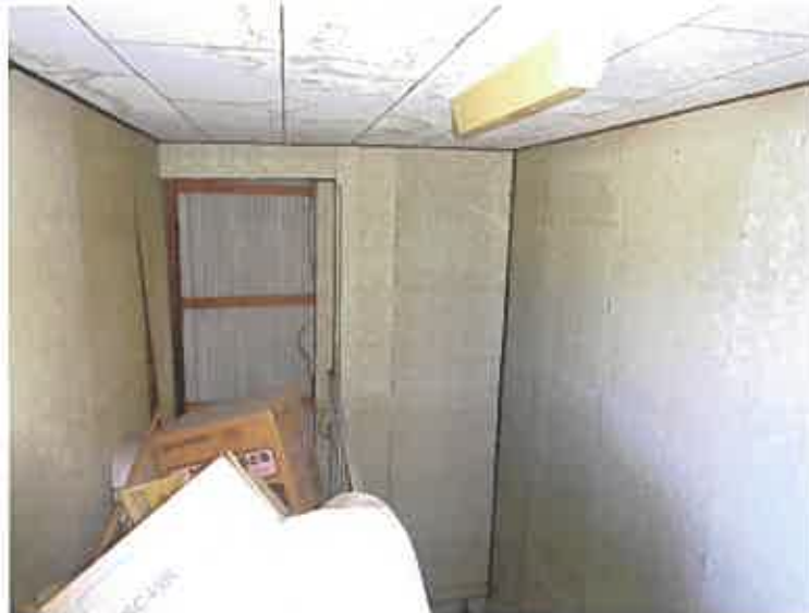
写真26 (物件2の建物 屋階)
