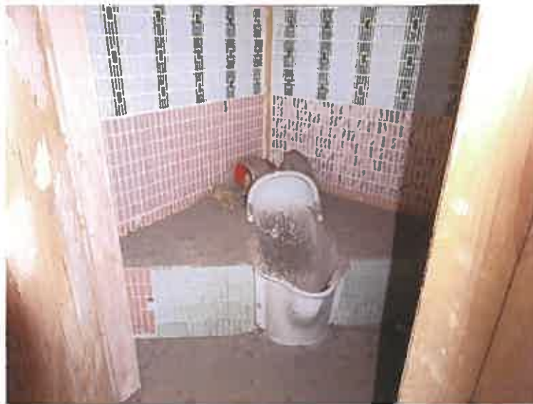
写真3 2 (物件3の建物 1階)
