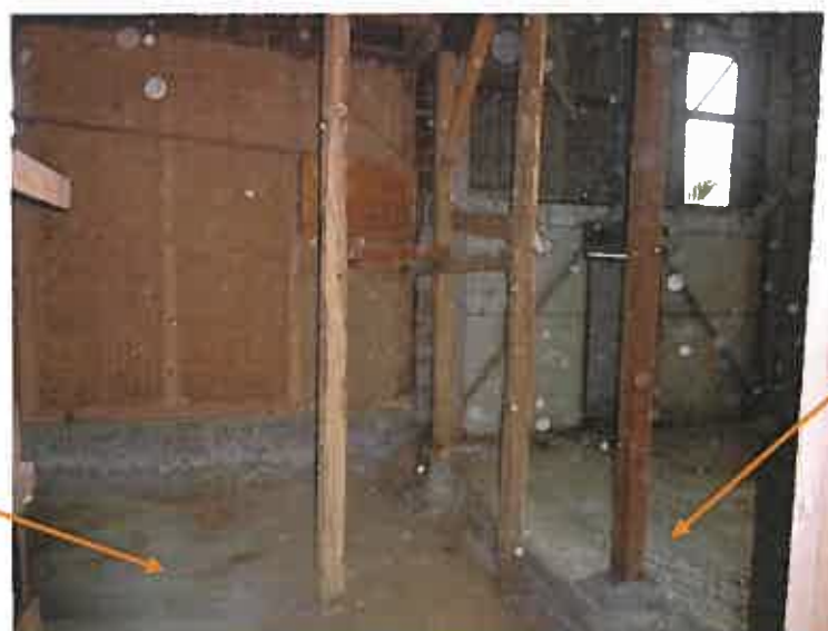
写真29 (物件3の建物 1階)
