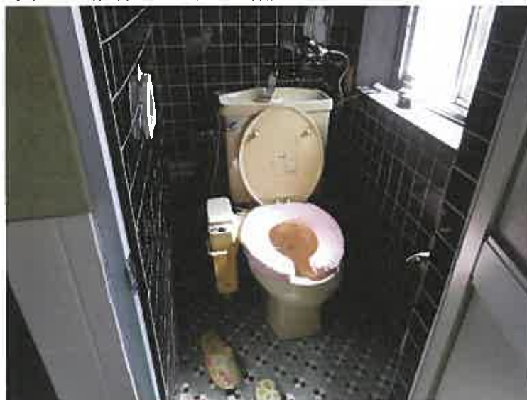
写真23 (物件2の建物 3階)
