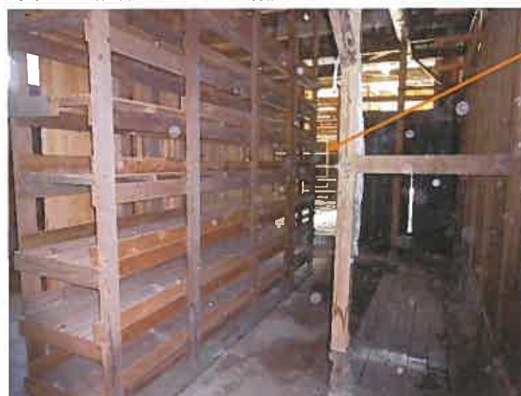
写真30 (物件3の建物 1階)
