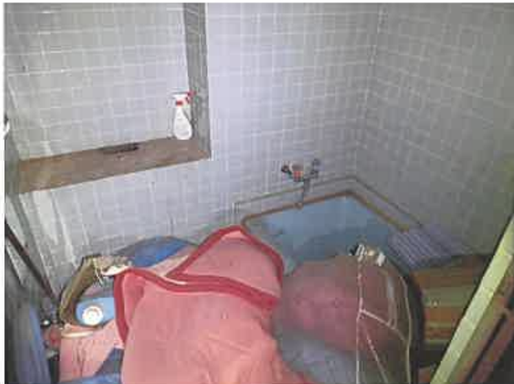
写真36 (物件3の建物 2階)
