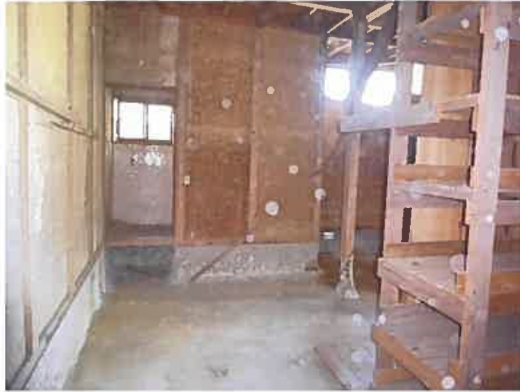
写真3 1 (物件3の建物 1階)
