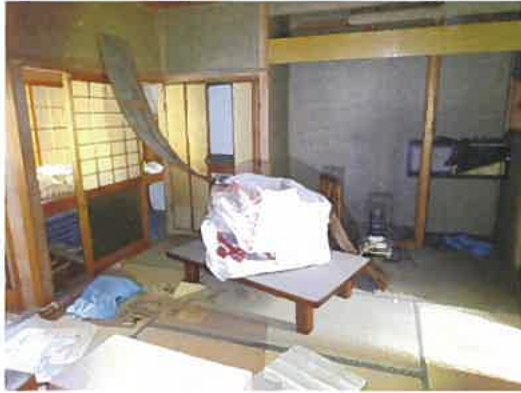
写真34 (物件3の建物 2階)
