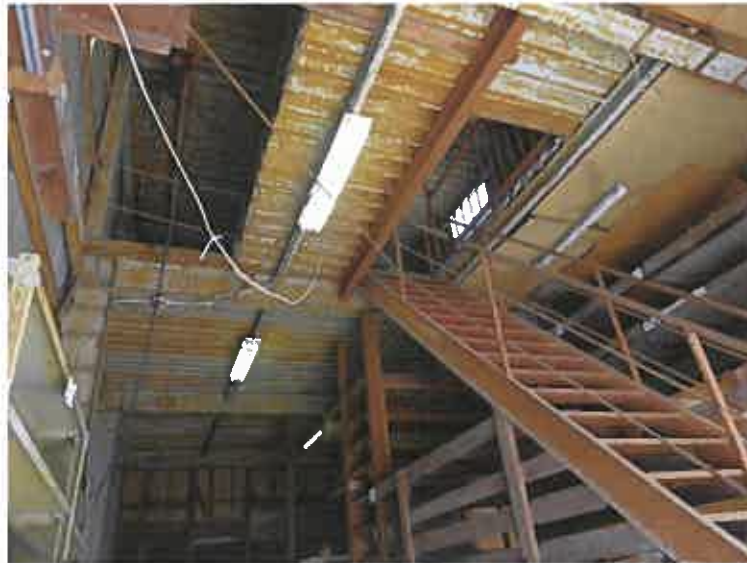
写真10 (物件2の建物 1階)
