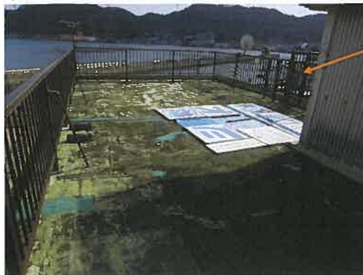
写真28 (物件2の建物 屋上)
