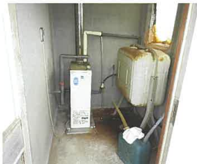
写真18 (本件建物 屋上)
