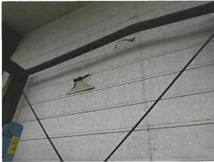
写真4 (本件建物の1階の外壁)
