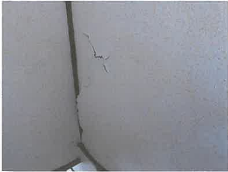
写真13 内壁の剥離
