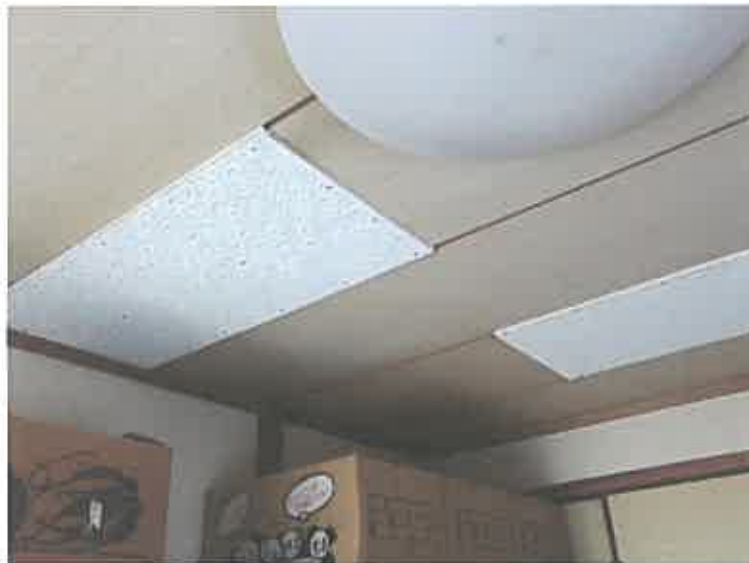
写真17 天井の補修板
