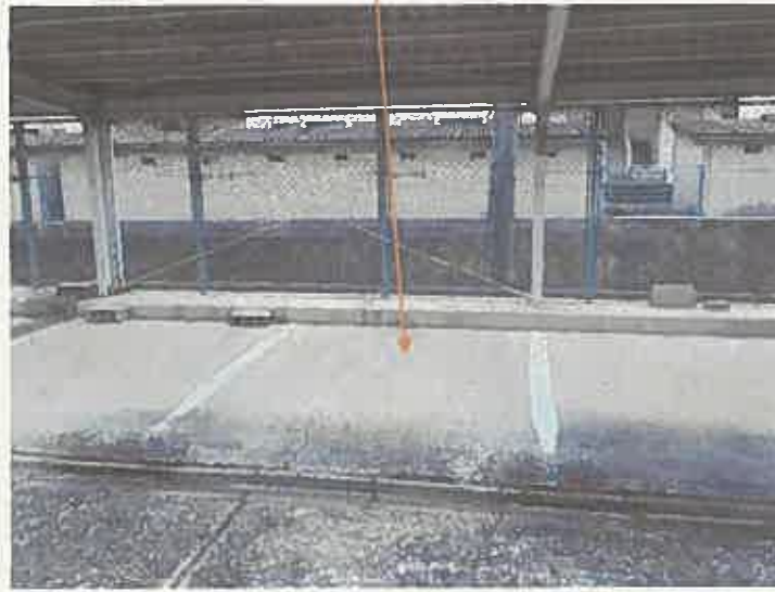
写真8 物件1 2建物(車庫) 区画B-10部分
