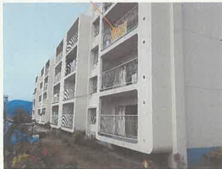
写真3 物件1 4建物（主たる建物）
