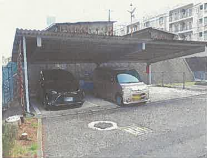
写真5 物件10建物(車庫)
