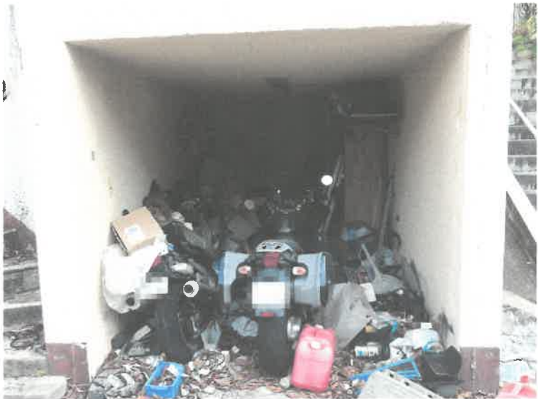
写真3 附属建物 (掘込車庫)
