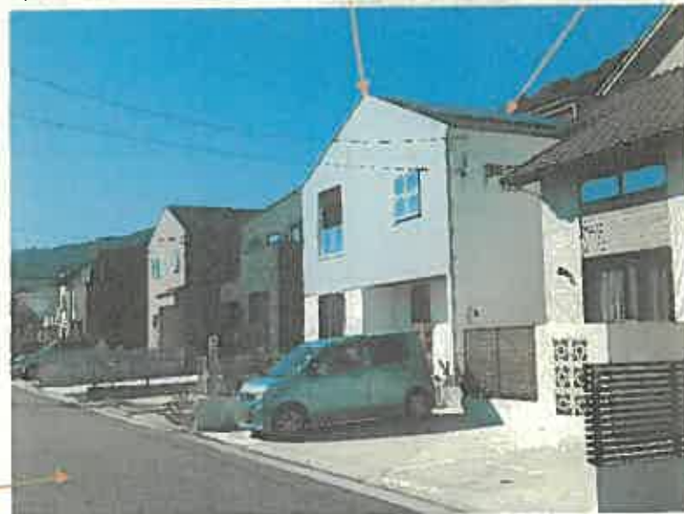
写真3 本件建物 太陽光発電設備 (ソーラーパネル)
