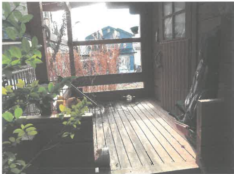
写真5 未登記附属建物
