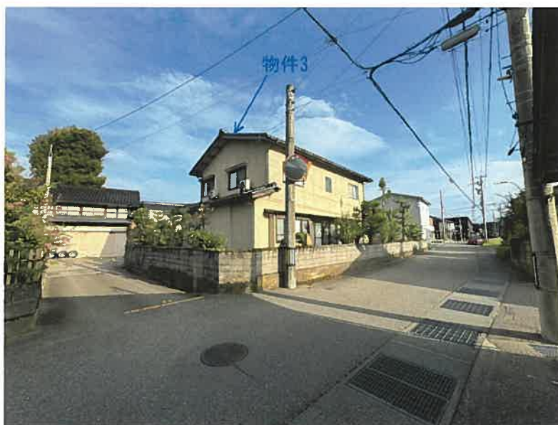
物件 1～3 「北西方より撮影」
