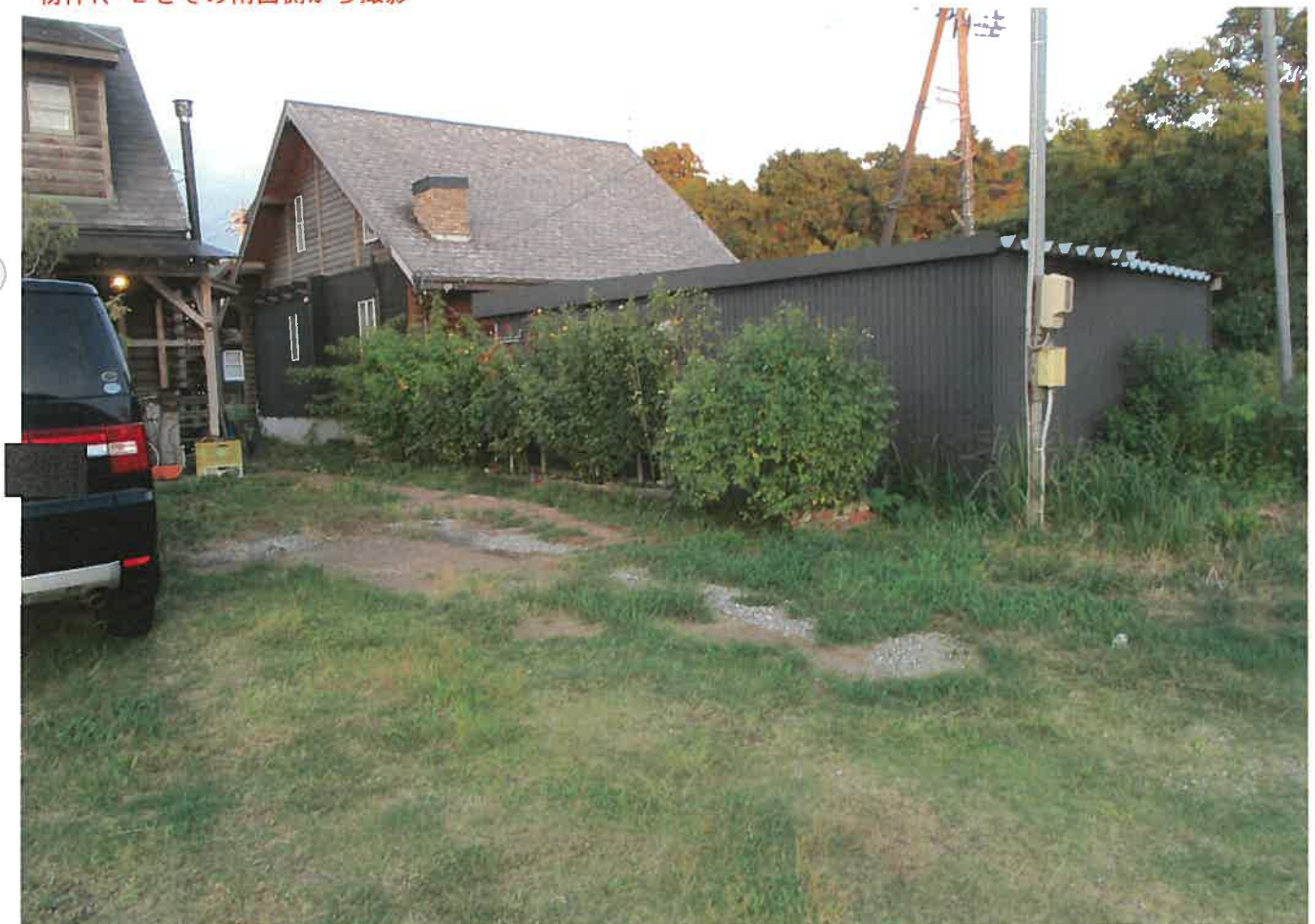
物件1、2をその北西側から撮影
