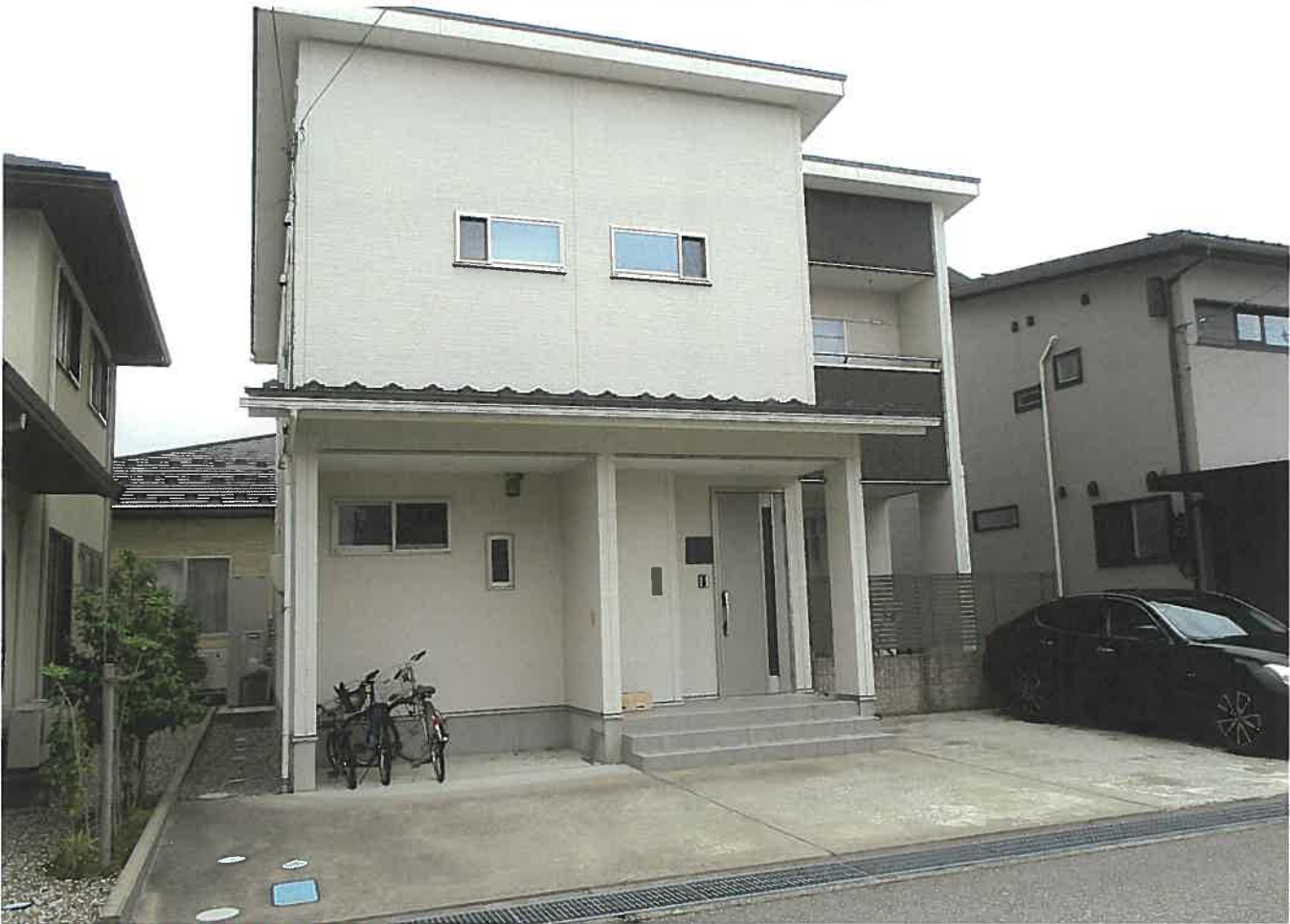
物件 1、2 をその北西側から撮影
