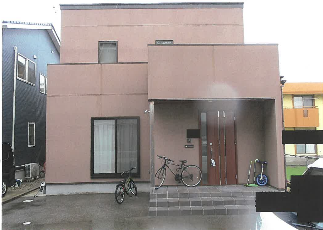
物件1、2をその南側から撮影
