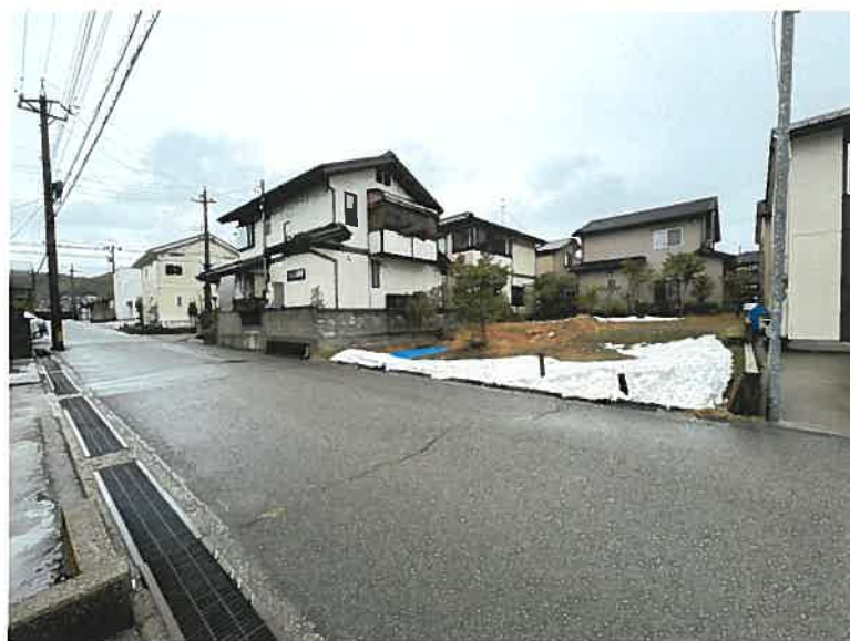
物件 1「北西方より撮影」
