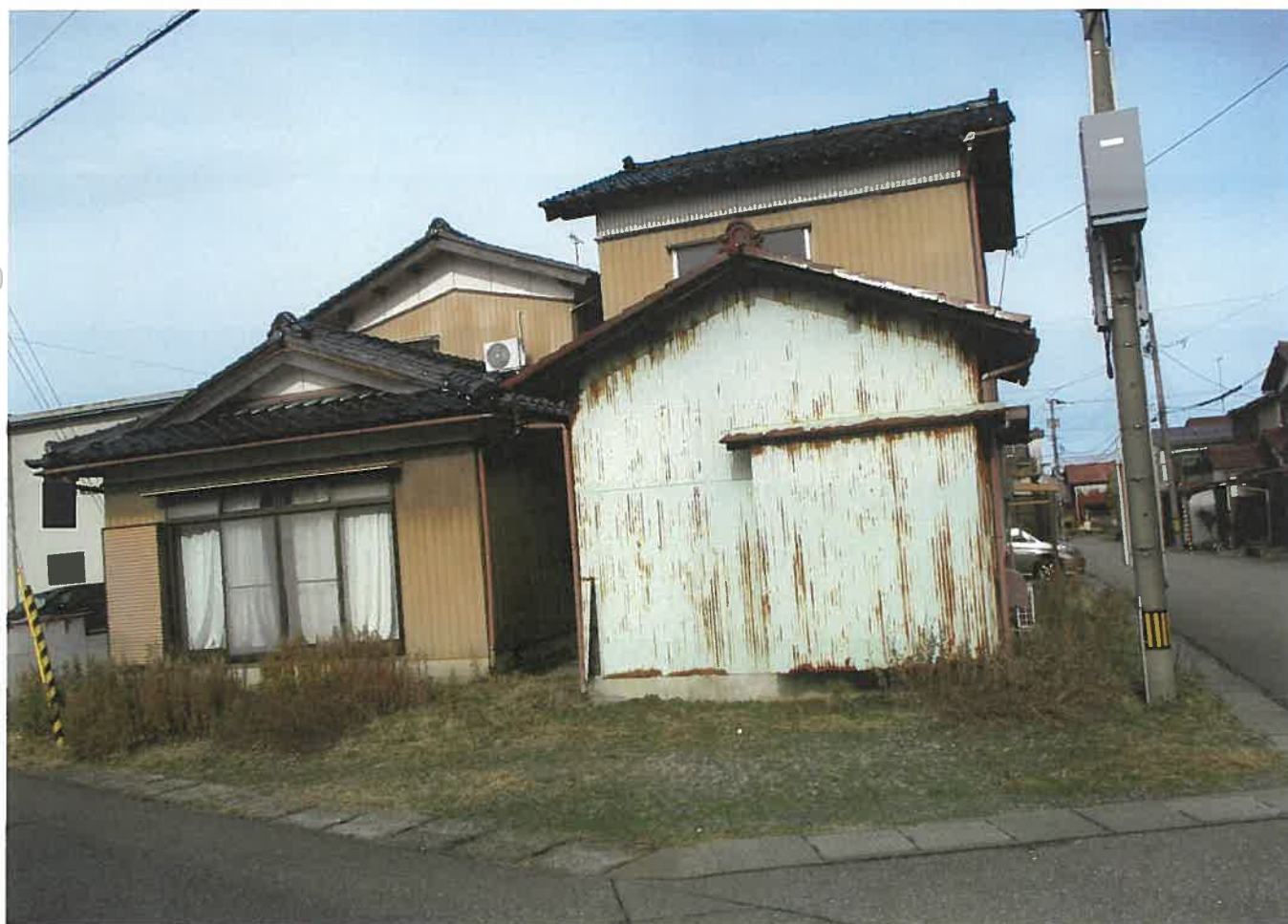
物件1、2の南東側から撮影
