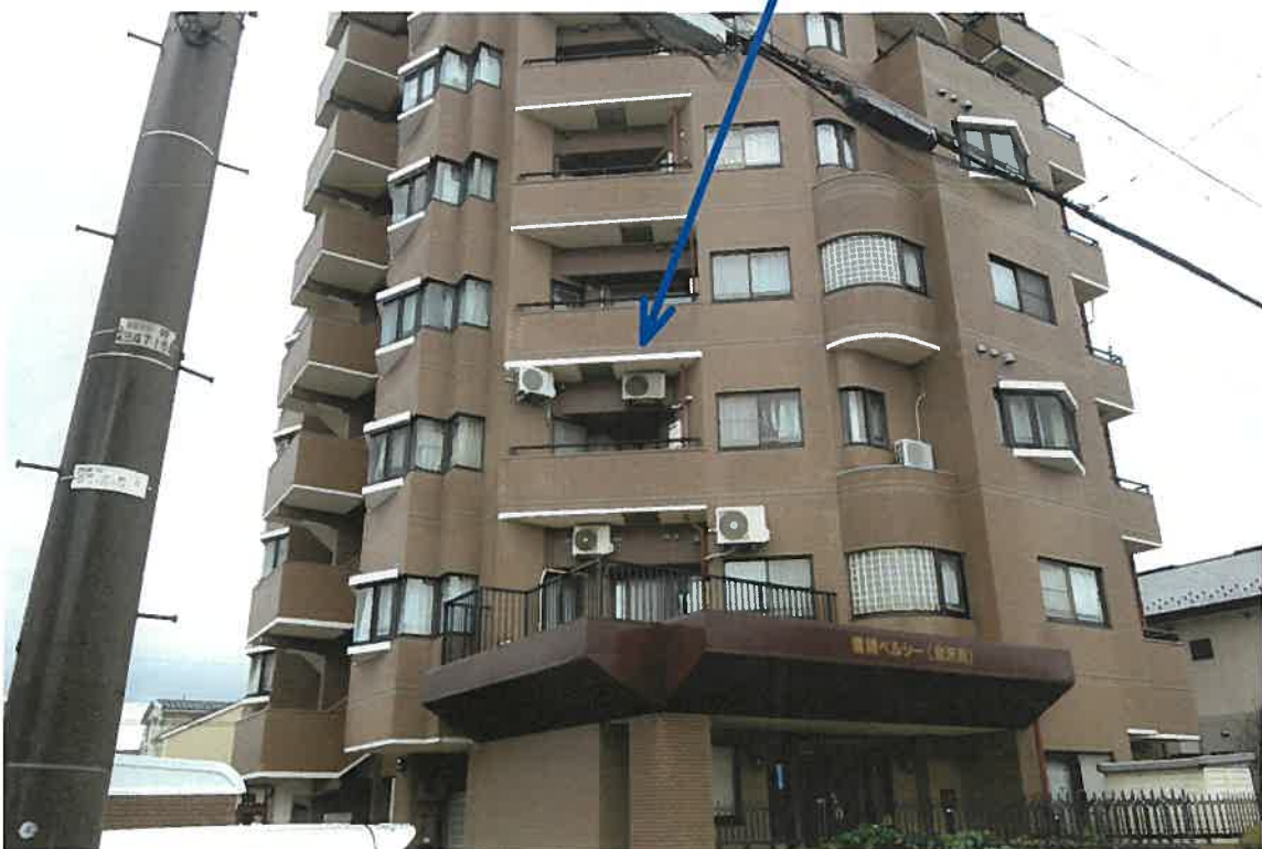
南東方向より撮影
