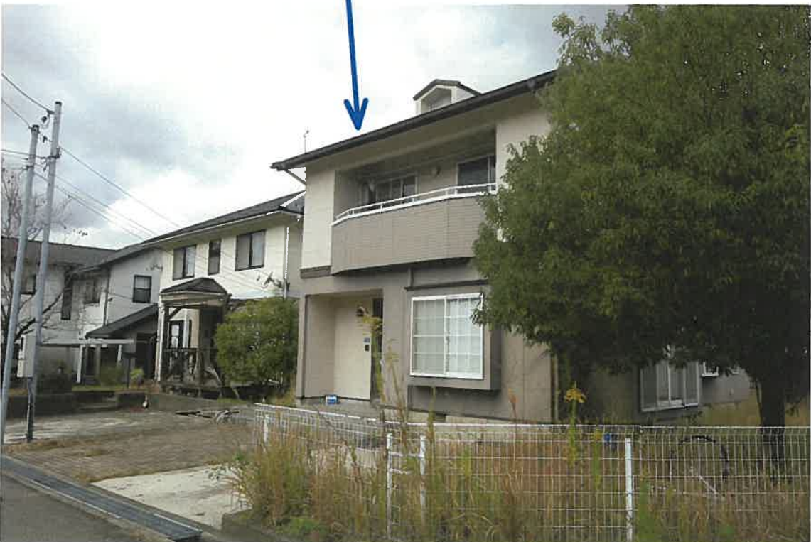
南東方向より撮影
