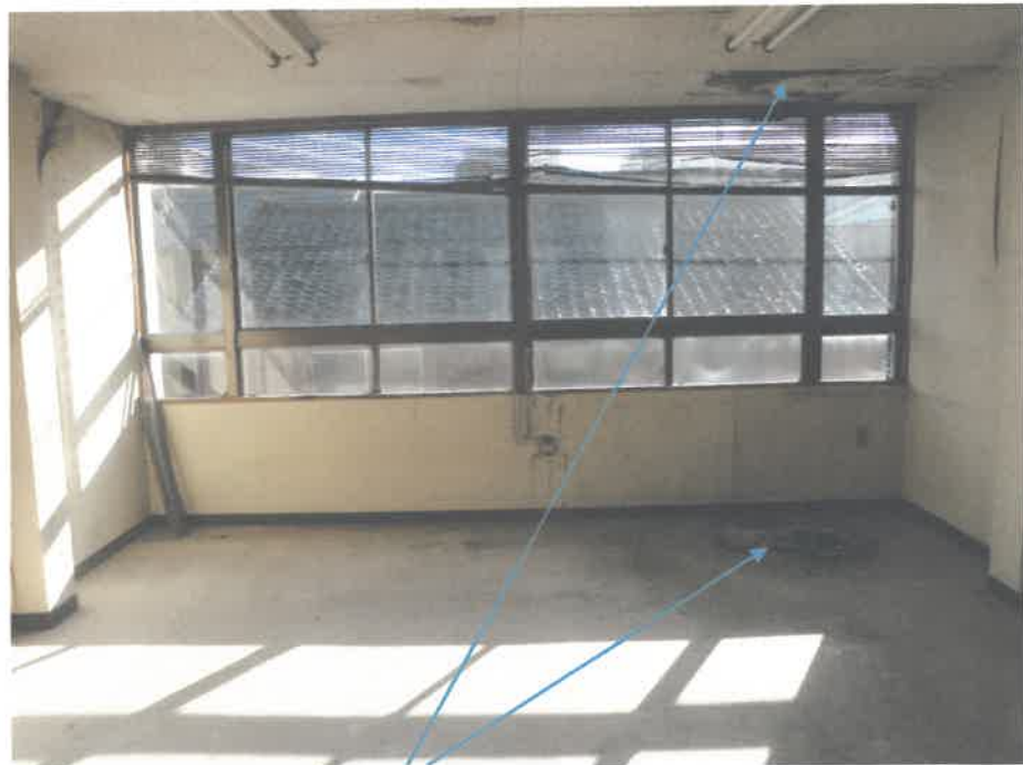
物件1 建物の内部を撮影
