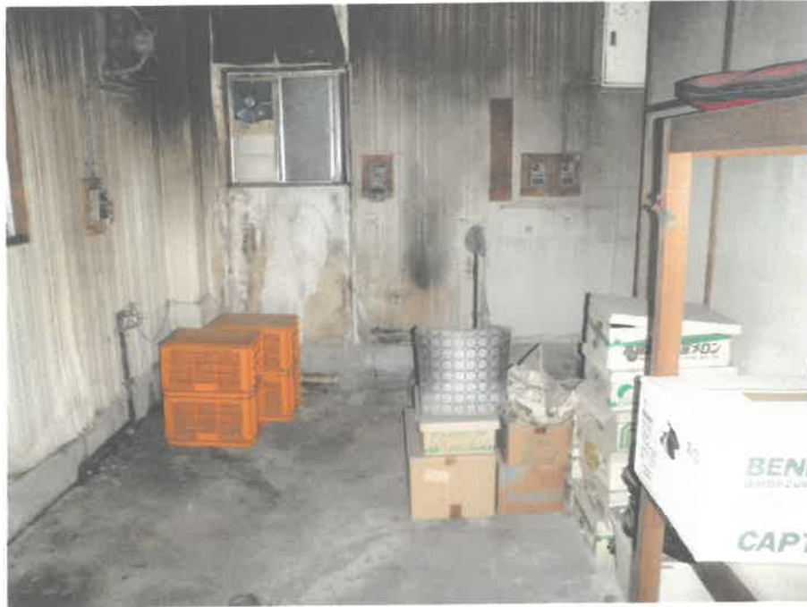
物件1 建物の内部を撮影
