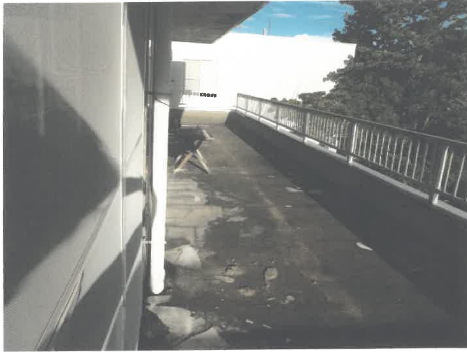
物件1建物のベランダを撮影
