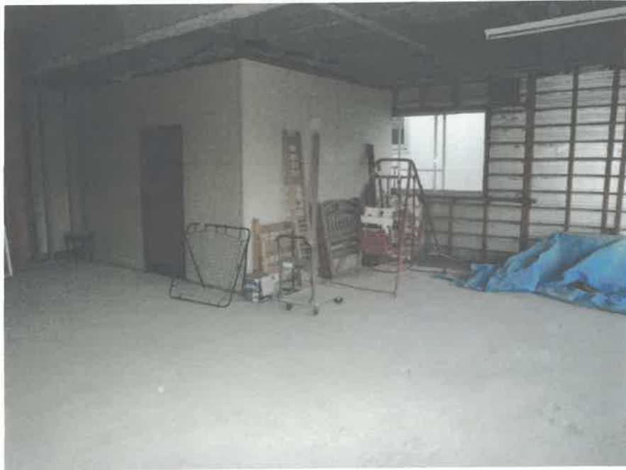
物件1 建物の内部を撮影
