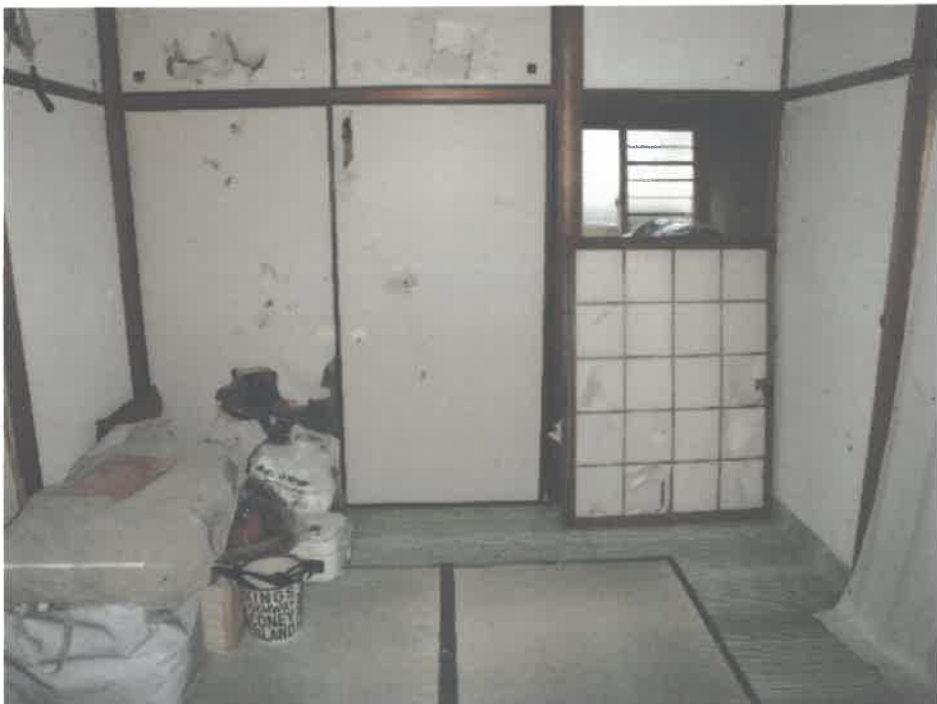
物件4建物の内部を撮影
