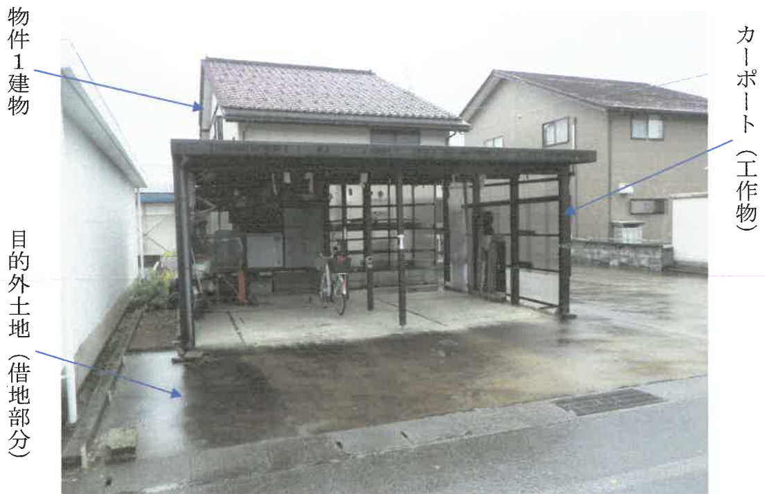
物件1 建物の外部 (カーポート (工作物)) を撮影
