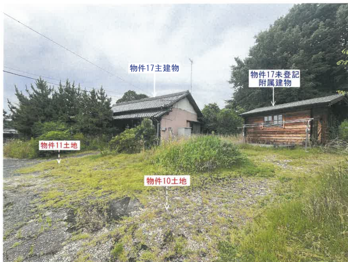
写真③ 物件土地内より撮影
