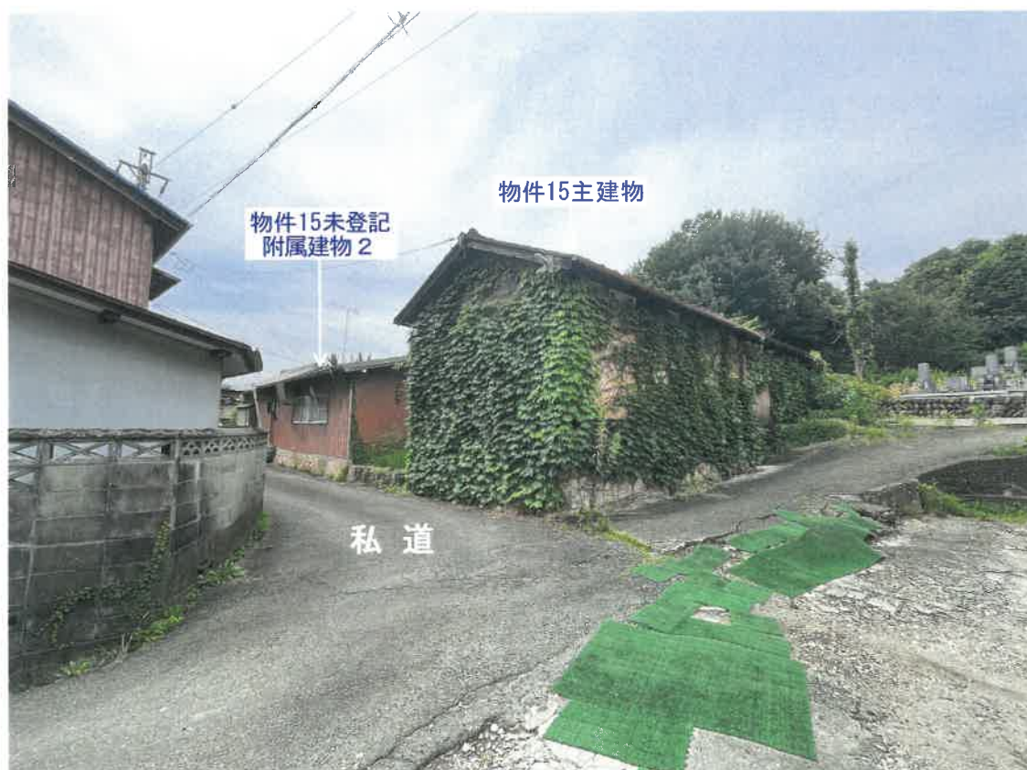
写真⑥ 南東方より撮影
