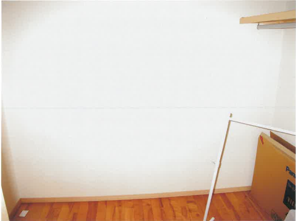
前同建物の2階室内
