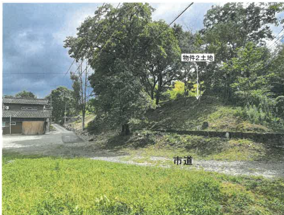
写真⑦ 北方より撮影
