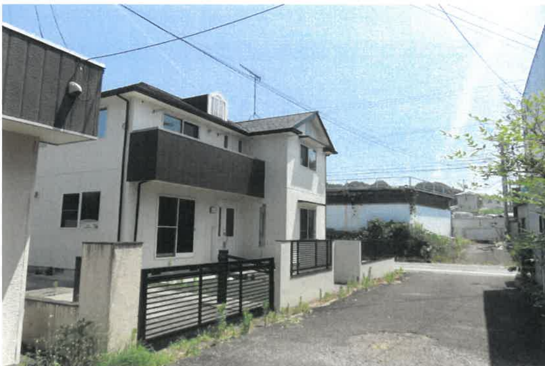
物件土地建物の南西方から撮影
