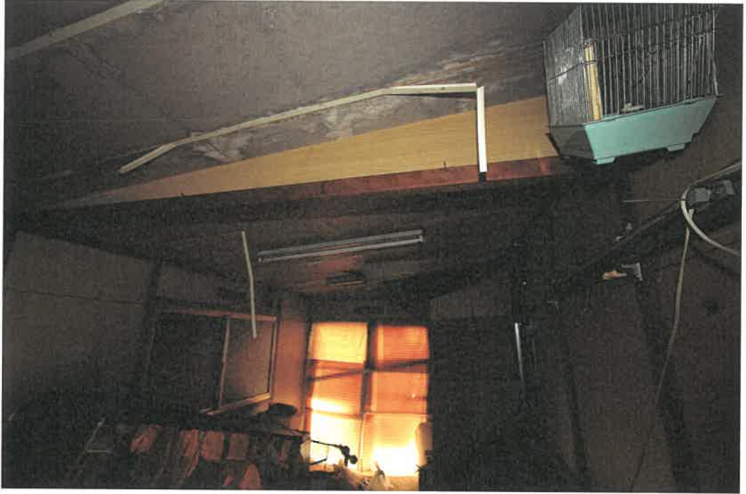
物件 2 附属建物室内
