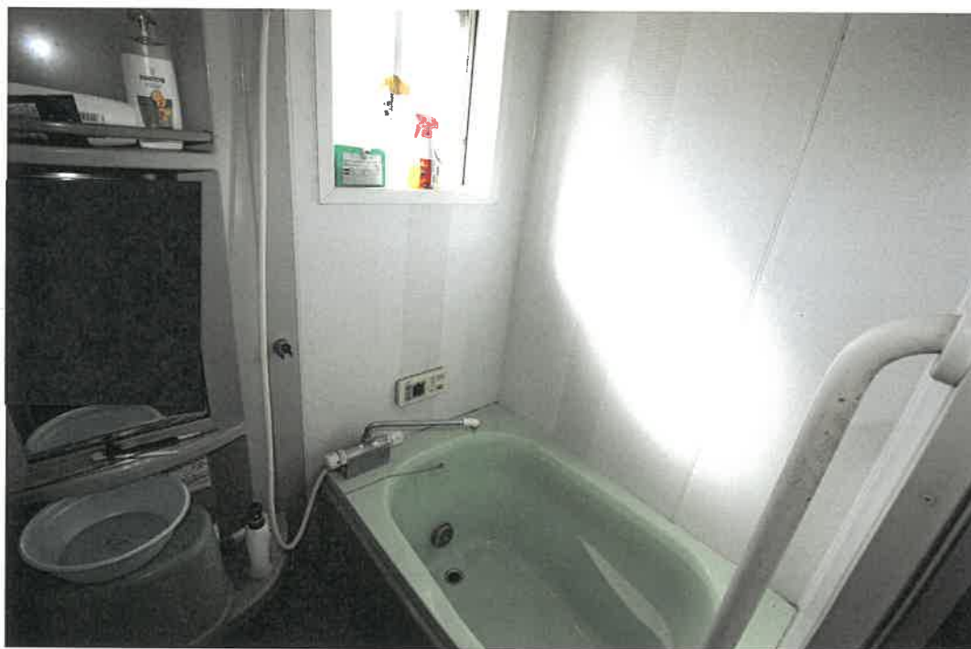
物件 2 主建物 1 階室内
