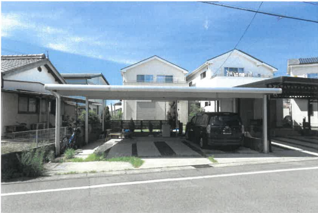
物件土地建物の南方から撮影
